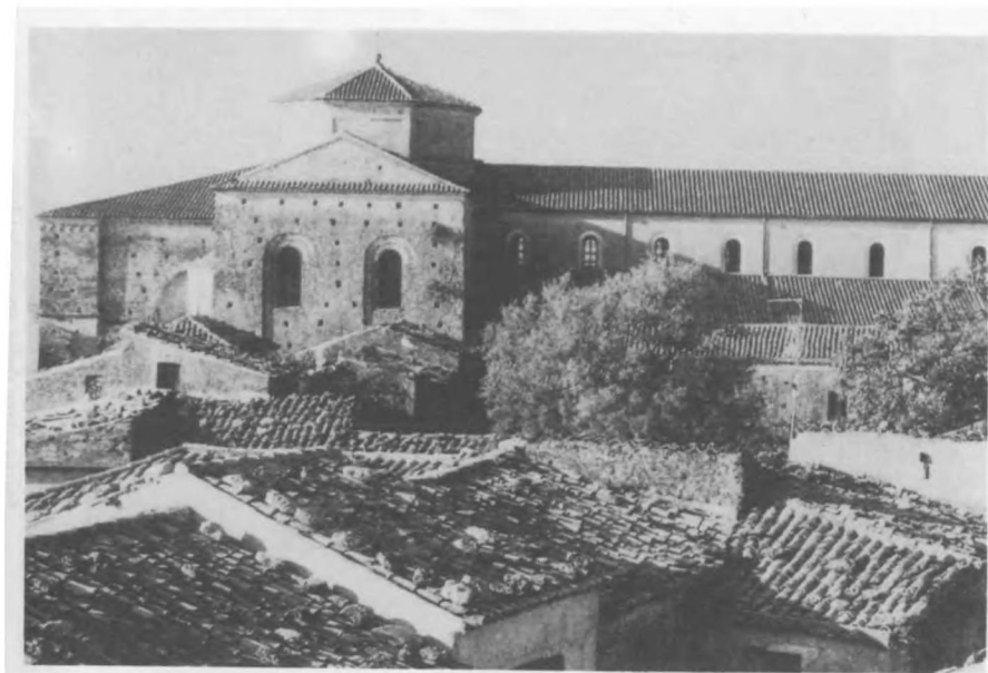
Foto. 5. — Gerace, cattedrale. Testata e fianco nord.
